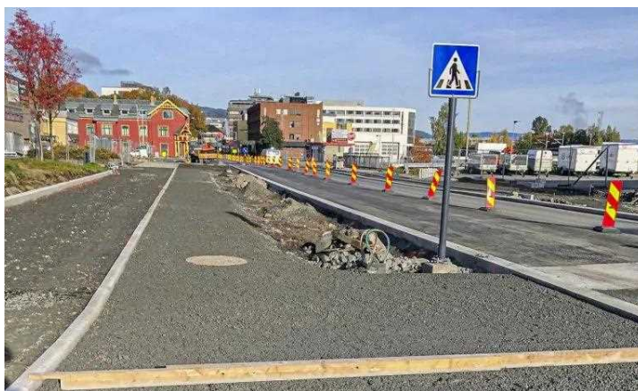
Anleggsarbeid i bymiljø.
